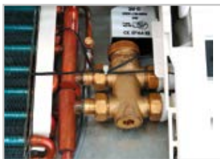
Ausführung 3-Wege-Ventil WLT 25-3 bis 85-3
