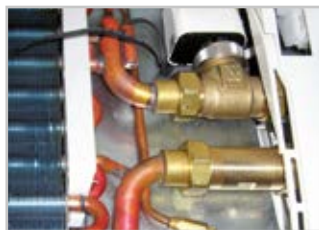
Ausführung 2-Wege-Ventil WLT 25-2 bis 85-2
